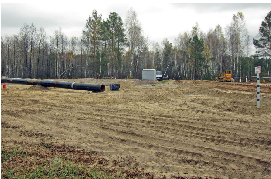
Рисунок 3.5.13 – Внешний вид участка строительства в момент обследования
