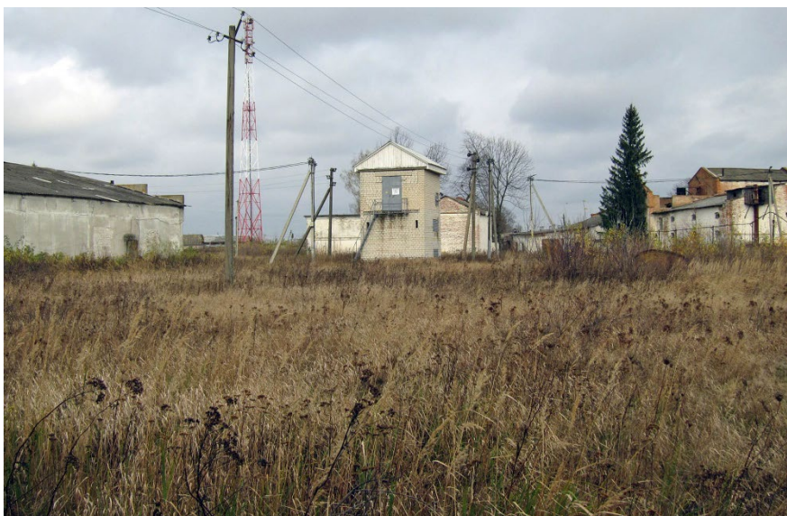
Рисунок 3.5.10 – Вблизи трансформаторной подстанции
